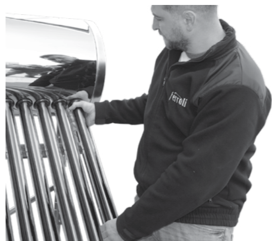
Țineți ferm tubul vidat, apoi introduceți-l și rotiți-l în gaura corespunzătoare din rezervor.
